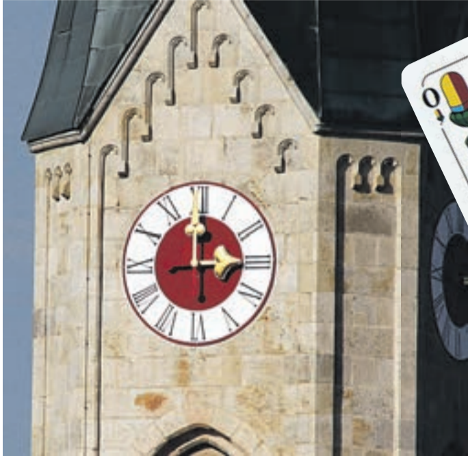
Der Kirchturm wird per Funk gesteuert, Foto: © Mertl
