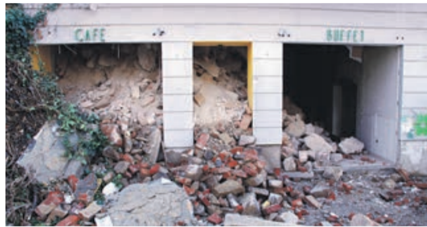
Aus für das Haus mit den grünen Fensterläden am Marktplatz: Vor wenigen Wochen wurde die ehemalige Bäckerei abgerissen, Foto: © Mertl
